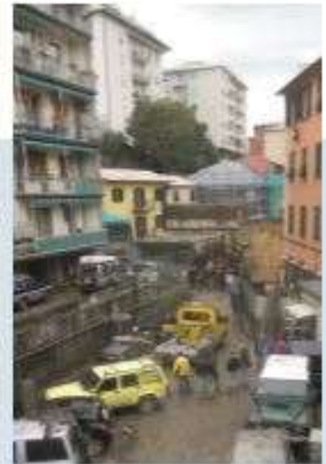
Genova, ottobre 2014. Via Pantelli, realizzata sulla copertura del Rio Vernazza, è stata devastata dalla furia del piccolo corso d'acqua, che ha trascinato via parecchi veicoli.
